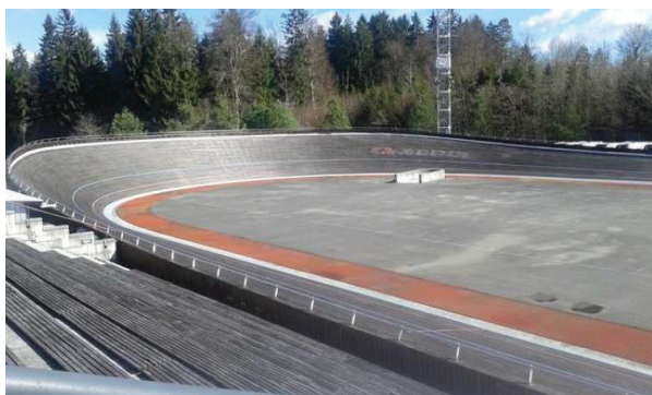
Slika 6b: Velodrom pred obnovo
