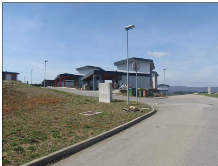
- omrežje javne razsvetljave vzdolž stanovanjske ulice -
