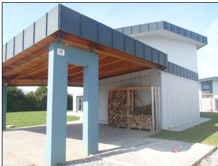
- tipološko usklajen nadstrešek pred stanovanjsko stavbo -
