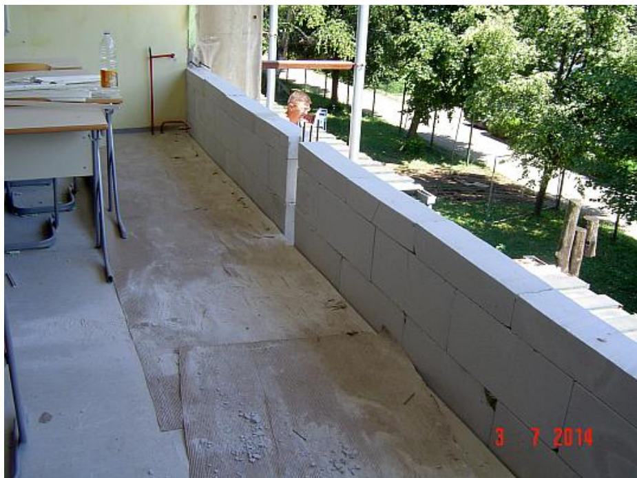
Slika 2 Zidanje novih parapetov
