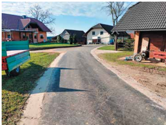
Asfaltiran odsek ceste na Daljnem vrhu
