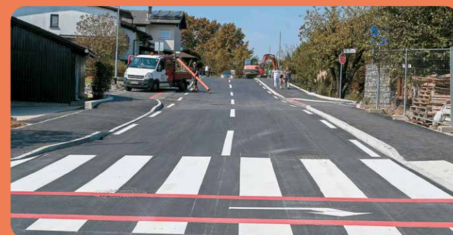
Zaključili smo celovito ureditev 150-metrskega odseka Westrove ulice od križišča s Šegovo ulico do križišča z Volčičevo, kjer smo uredili vozišče, cestno razsvetljavo in kanalizacijo ter poskrbeli za varne površine za pešce in kolesarje.
