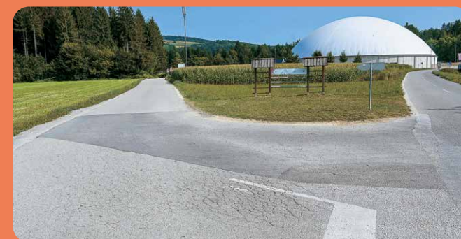
Začela se je prva faza ureditve križišča in nove ceste v Češči vasi v dolžini 340 metrov, ki bo vodila od Zaloške ceste proti konjeniškemu centru. Del ceste do Olimpijskega centra Novo mesto bo potekal po novi trasi in bo nadomestil trenutno cestišče do velodroma, preostali del obstoječe ceste od velodroma do konjeniškega centra bo razširjen, celotna pot pa bo namenjena tudi pešcem in kolesarjem.
