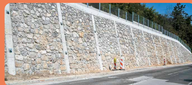
Zaključena je sanacija pobočja in gradnja kamnitega opornega zidu, s čimer smo Seidlovo cesto zaščitili pred padajočim kamenjem in zemljino, pod urejeno brežino pa se je začela rekonstrukcija cestišča. Na Seidlovi cesti bodo urejene tudi površine za pešce in kolesarje ter avtobusno postajališče.
