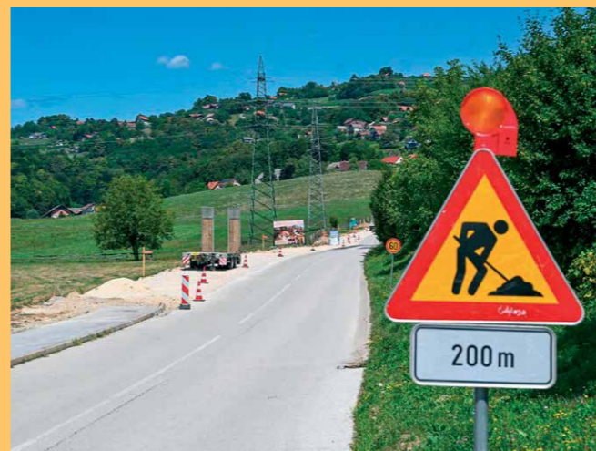
Nadaljujemo prizadevanja za prometno varnost in trajnostno mobilnost z gradnjo nove kolesarske povezave proti Trški gori, ki bo kolesarjem zagotovila varno in udobno pot.
