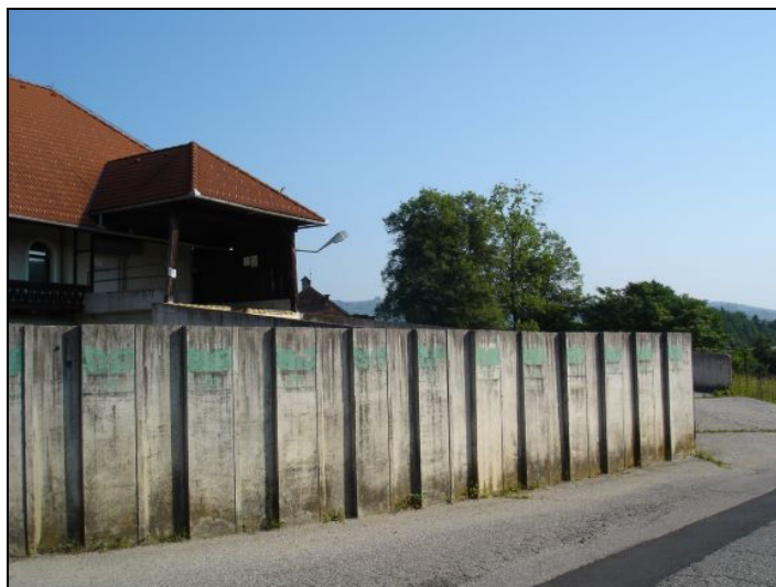
- betonski zid ob lokalni cesti -
