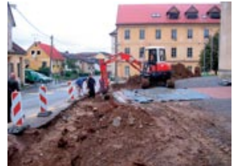
Gradbena dela so potekala ob budnem nadzoru arheologov
