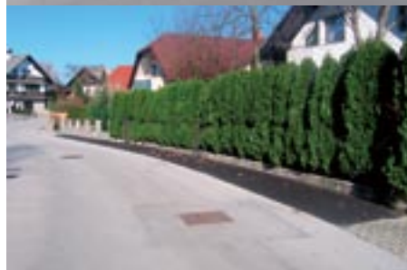
Novi pločniki po Košenicah in na njeni Vorančevi ulici
