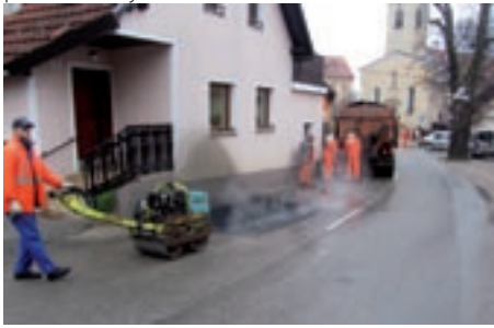
Sanacija cestišča ob Rolihovi hiši
