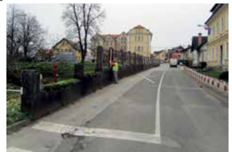
Delavci med odstranjevanjem poškodovane betonske ograje
