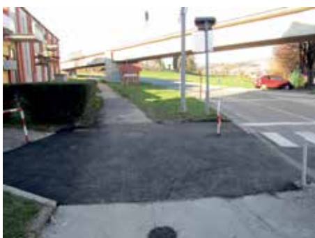
Po kvalitetno izvedeni sanaciji ni več težav
