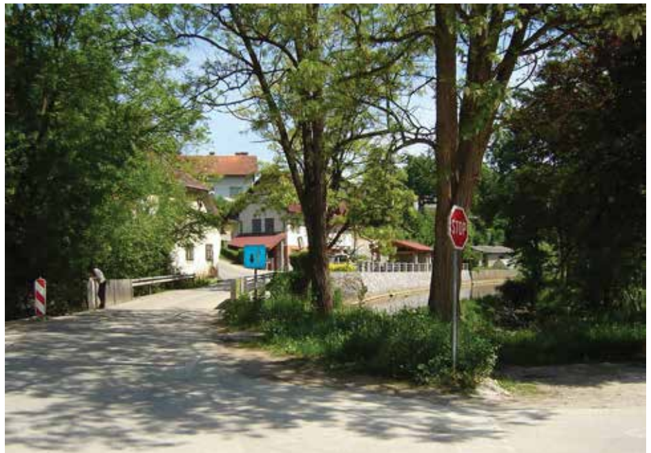
Obstoječi most čez potok Težka voda
