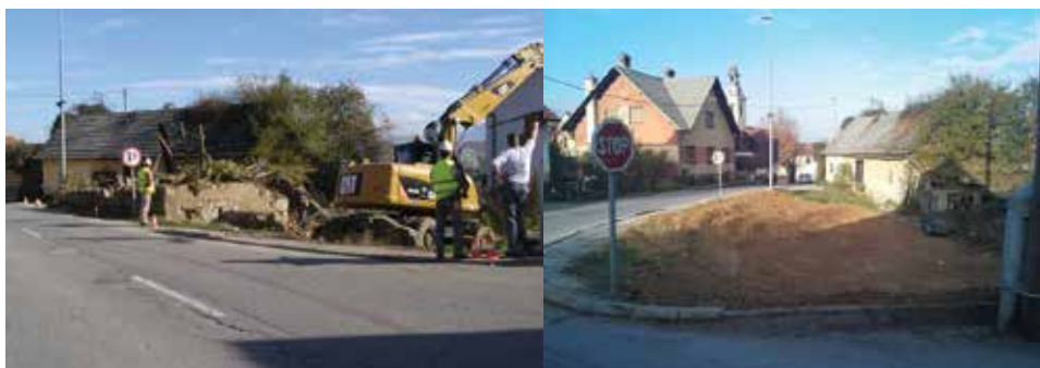
Postopek odstranitve objektov Burgerjeve domačije, kjer je na koncu nastalo veliko prostora za ureditev novega uvoza, avtobusnega postajališča in pločnikov, predvsem pa vse bolj lepo in varno
