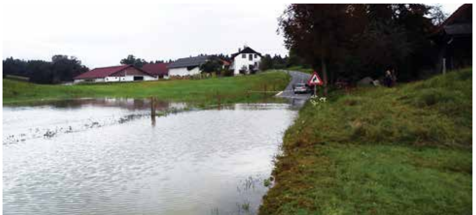
POPLAVLJENA CESTA – Levo Vidmarjeva domačija in desno Veselova, vmes pa cesta, ki povezuje Novo mesto s Semičem. Prometa na cesti je vse več, potniškega, pa tudi tovornega, tako da bo zelo nerodno, če se bodo poplave pogosto pojavljale, saj je odtok vode, kot je na fotografiji lepo videti, popolnoma zaprt. (Foto: Brigita Juršič)
