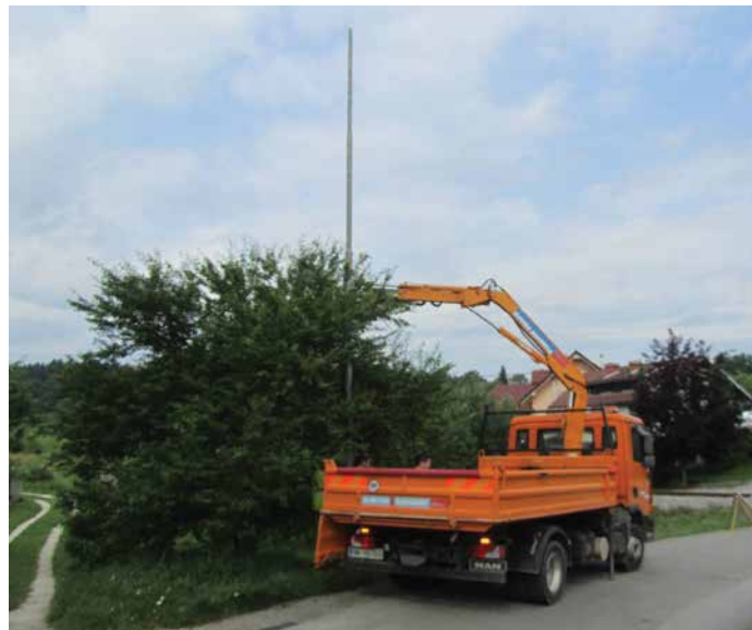
Potek postavitve nove – dodatne svetilke.
