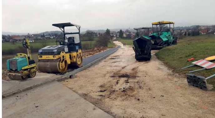
Cesta s pločnikom se je pričela asfaltirati 12. decembra 2017, delo pa so bila zaključena že naslednji dan.
