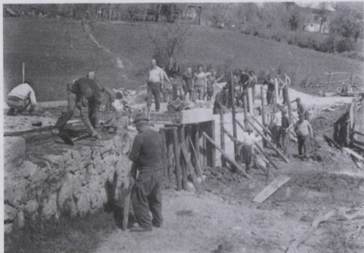
Gradnja mostu v Stranski vasi čez potok "Vejar" l. 1975:
