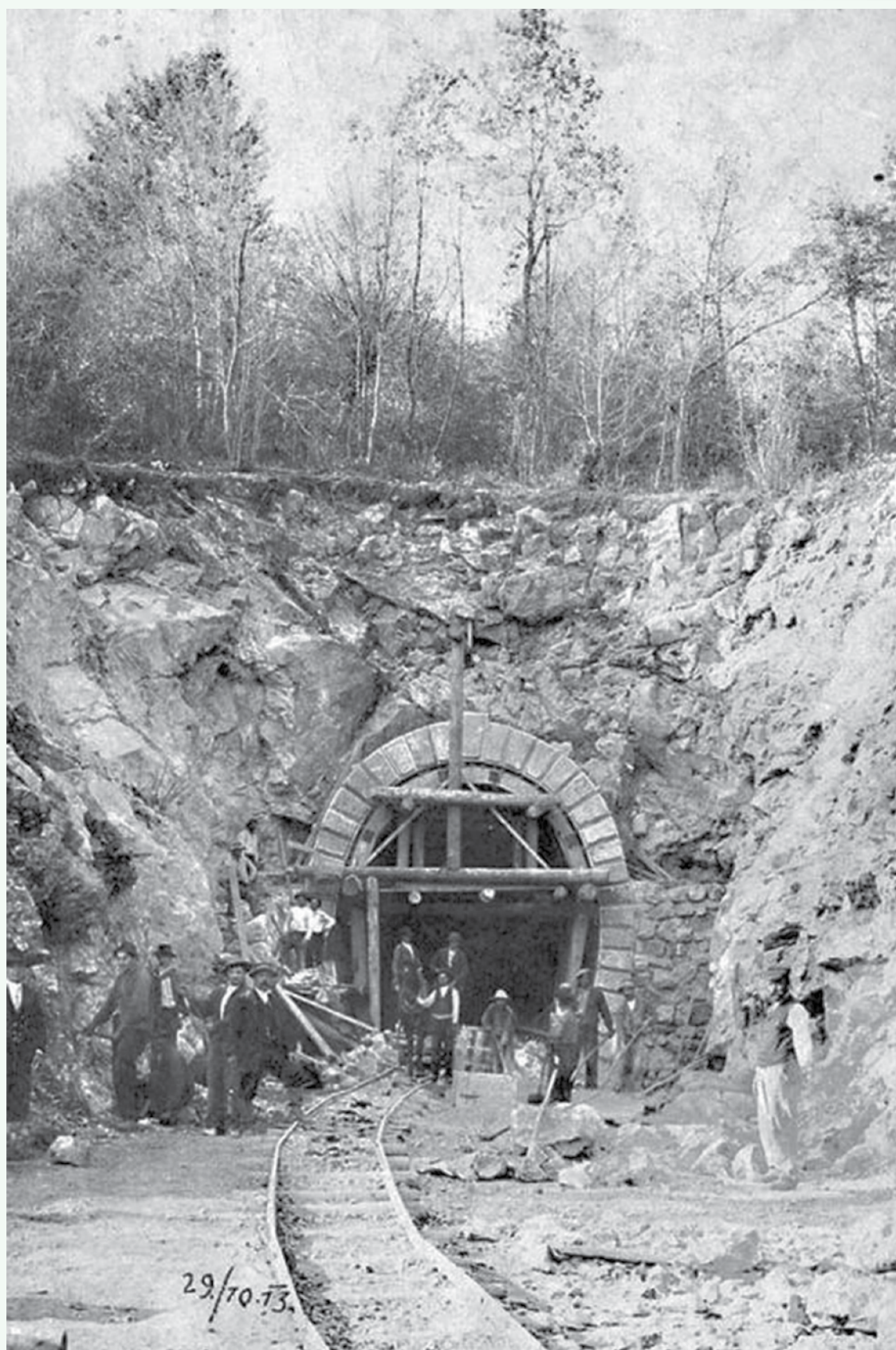
Gradnja tunela Ruperč Vrh, 1913. leta.
