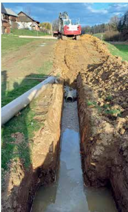
Vrh pri Ljubnu – pričetek gradnje
