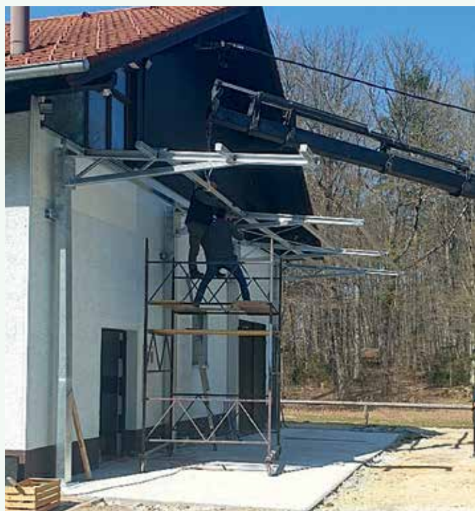
Postavljanje konstrukcije nadstreška za lovsko kočo.
