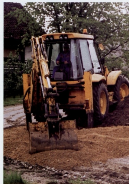
Priprava ulice za asfaltiranje v Birčni vasi.
