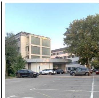
Pogled na območje urejanja z obstoječega parkirišča, vir: Topos d.o.o.
